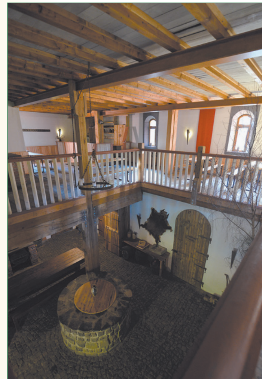
Innenausbau: Selbstverständlich wurde in der Burg der heimische Rohstoff Holz auch als Baumaterial eingesetzt. Die Balken und Bretter von Lärche und Douglasie stellte „MANN Naturenergie“ den Ehrenamtlern für ihr Projekt zur Verfügung.
