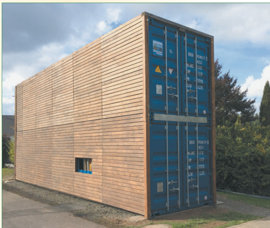
Passend: Die Holzverkleidung verleiht der umweltschonenden Anlage in Rhaunen eine natürliche Optik.
