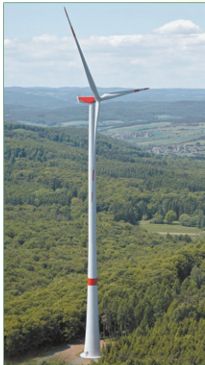
Ausblick: So sieht die hochmoderne „N117“ aus, die in Oberdreisbach installiert werden darf.
