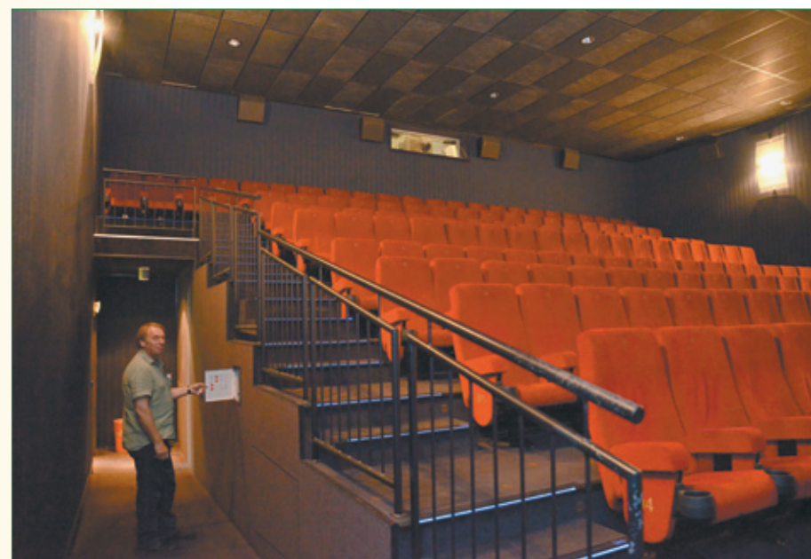
Beleuchtung: Die Energiemenge, die Uli Hüsch zum Erhellern der Säle braucht, ist gering. Der Projektor hinter der Scheibe in der Rückwand zieht mehr Strom.
