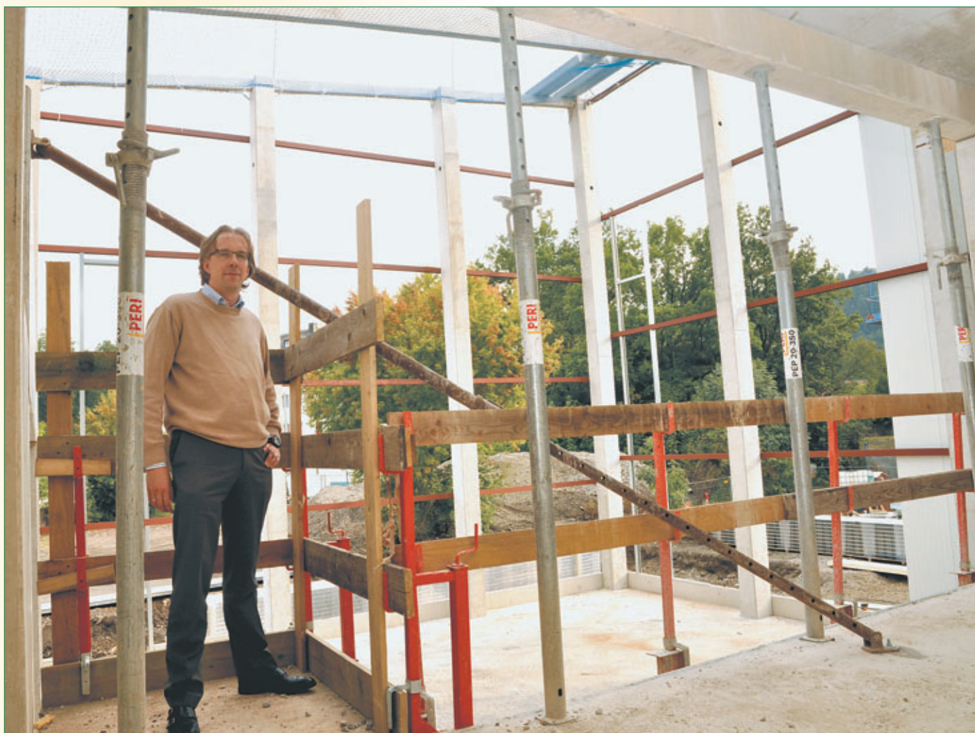
Baustelle: Noch pfeift der Wind durch, doch Ludger Felbecker freut sich schon, dass hier bald 150 Routen locken: „Ich hoffe, dann komme ich auch mal wieder zum Klettern.“
