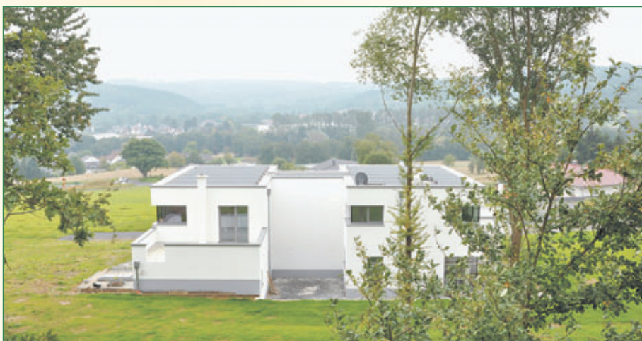
Energieerzeugung: Auf dem Dach seines Hauses betreibt Daniel Rahn eine Photovoltaik-Anlage.
