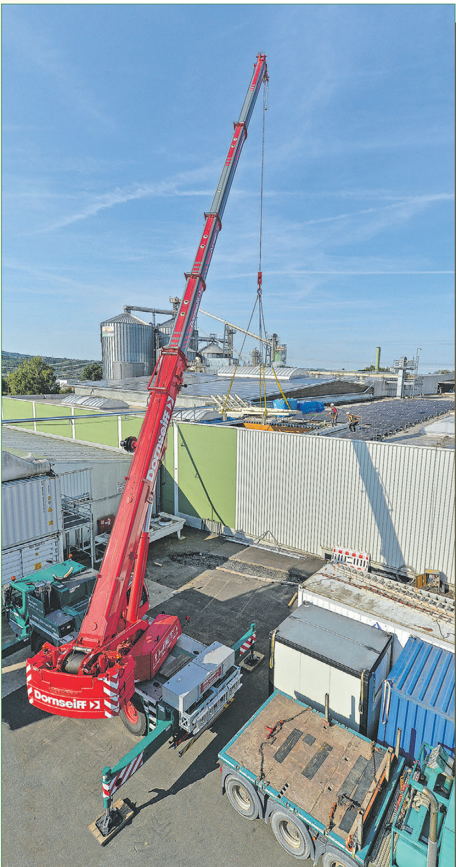
Baustelle: Einige der tonnenschweren neuen Teile müssen durch das Dach ins bestehende Sägewerk.
