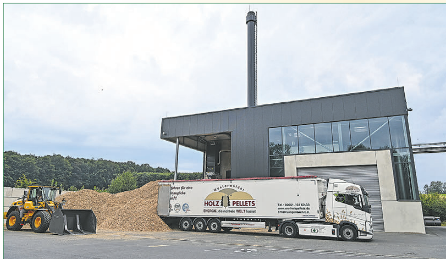
Energie: Die Hackschnitzel werden zur Wärmeerzeugung genutzt. Fotos: Schmalenbach
