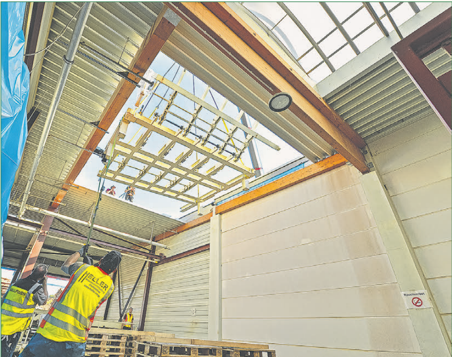
Enge: Nicht viel Platz in der Dachöffnung für die „einschwebenden“ Bauteile.
