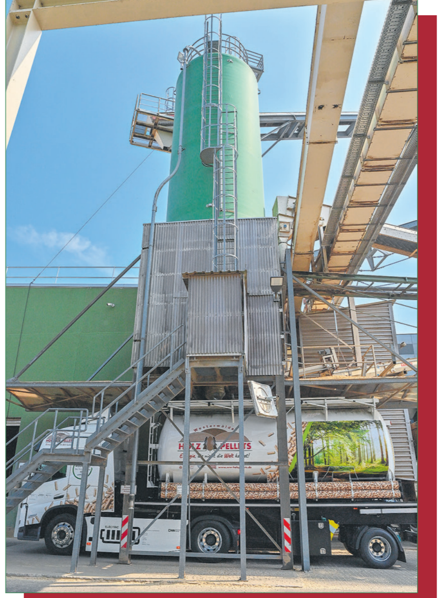
Tanken: Natürlich muss nicht nur Strom nachgeladen werden – auch Westerwälder Holzpellets muss Ramon Perilli auffüllen...
