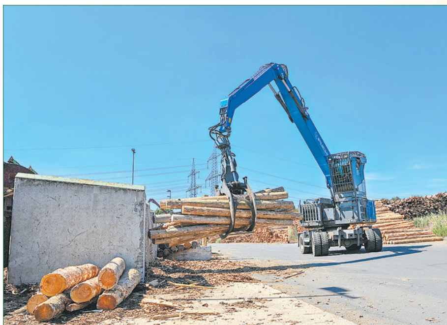
Klopfen: Das Holz wird an der Box ausgerichtet.
