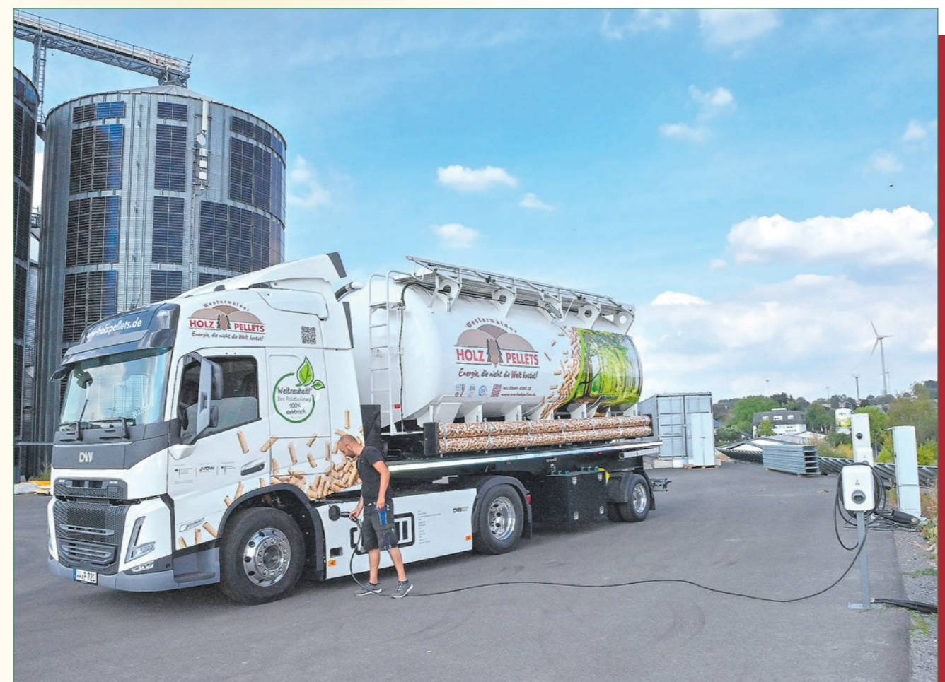
Arbeitsende! Fahrer Ramon steckt eines der Ladekabel an – darin fließt Strom aus den Solarzellen an den Pelletsilos hinter dem Lkw oder dem Windpark Langenbach am Horizont. Kommt von dort nicht genug, springt der Großspeicher im Container ein.
