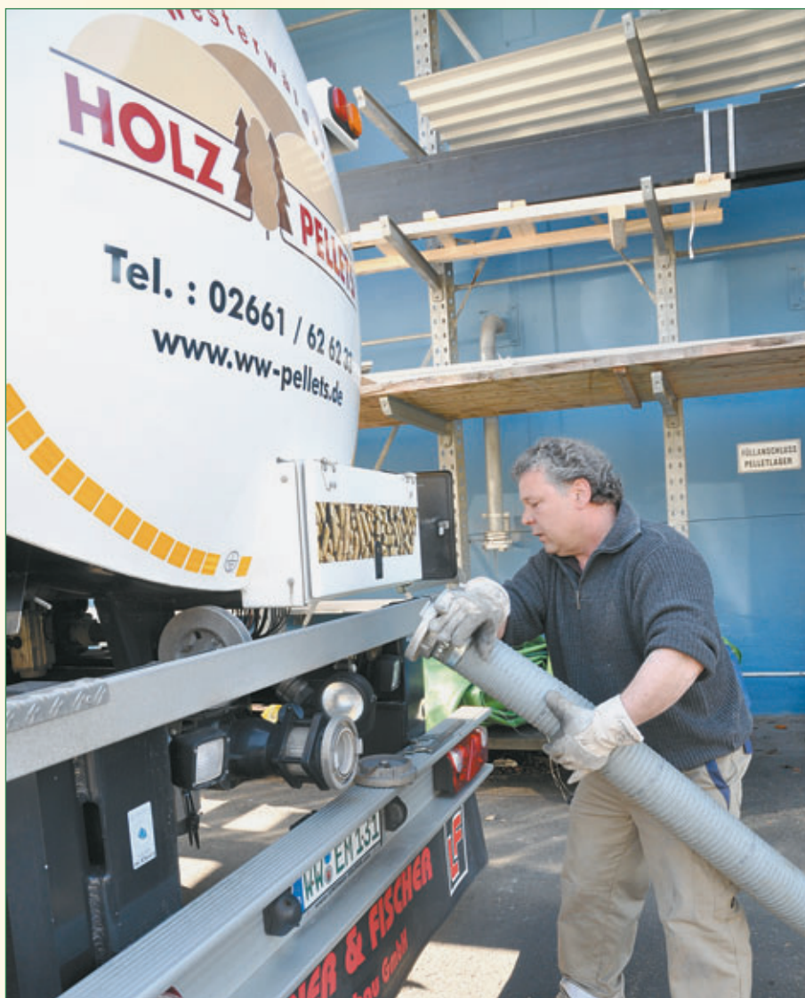
Anschluss: Mit dicken Schläuchen verbindet Edgar Benecke Silo-Wagen und Pelletbunker.
