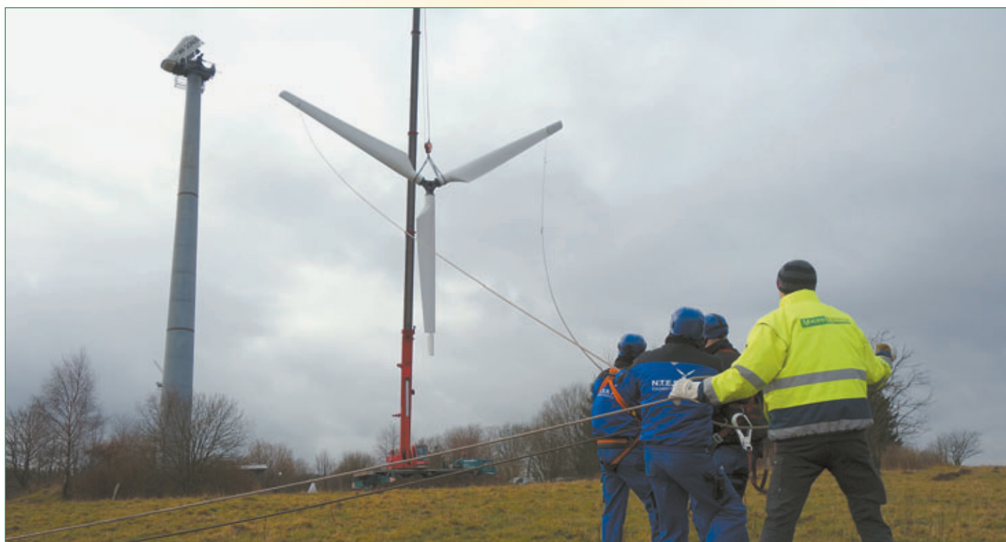
Modernisierung: „MANN ENERGIE“ baut vier alte Windräder ab und ersetzt sie durch eine neue Anlage.
