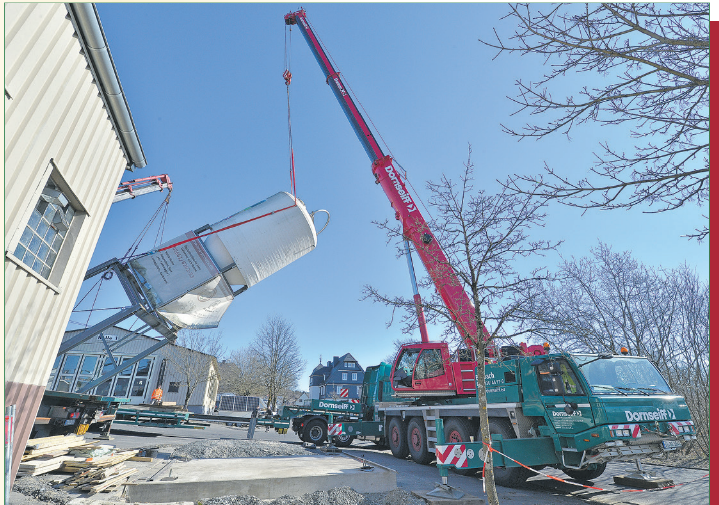
Standort: Per Kran wurde die 14 Meter hohe „Pellettankstelle“ nun direkt am Langenbacher Schulweg aufgestellt. Foto: Schmalenbach
