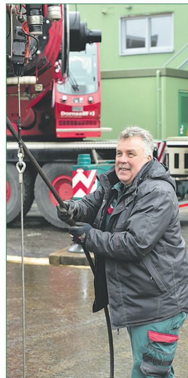
Experte: Beim „Umschwenken“ wird die benötigte Anzahl an Hubseilsträngen vorbereitet, erläutert Henni Judt.
