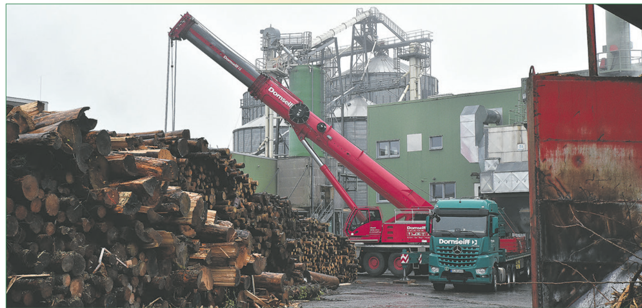
Beginn: Vor dem Hebevorgang muss der Kran zwischen Pelletsilos und Holzstapeln genau positioniert und mit Ballast von einem zweiten Fahrzeug beschwert werden.
