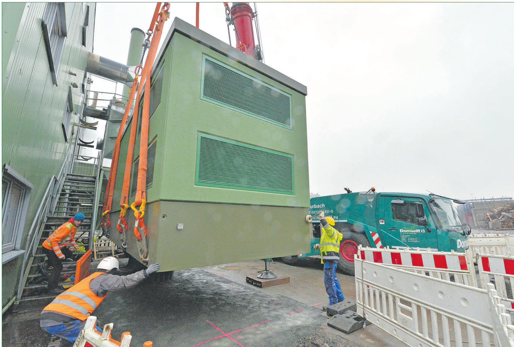
Verfahren: Sehr, sehr langsam lässt der Kran den Trafo auf seinen Standort sinken, wo er genau auf vorinstallierte Anschlüsse passen muss. Fotos: Schmalenbach
