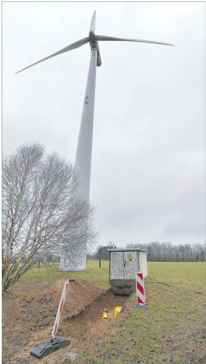
Beitrag: Am Windpark oberhalb von Langenbach „verschwindet“ das Kabel in der Erde, das über fast zwei Kilometer zum neuen Trafo führt und die Windenergie so ins Netz bei den WWP einbindet.
