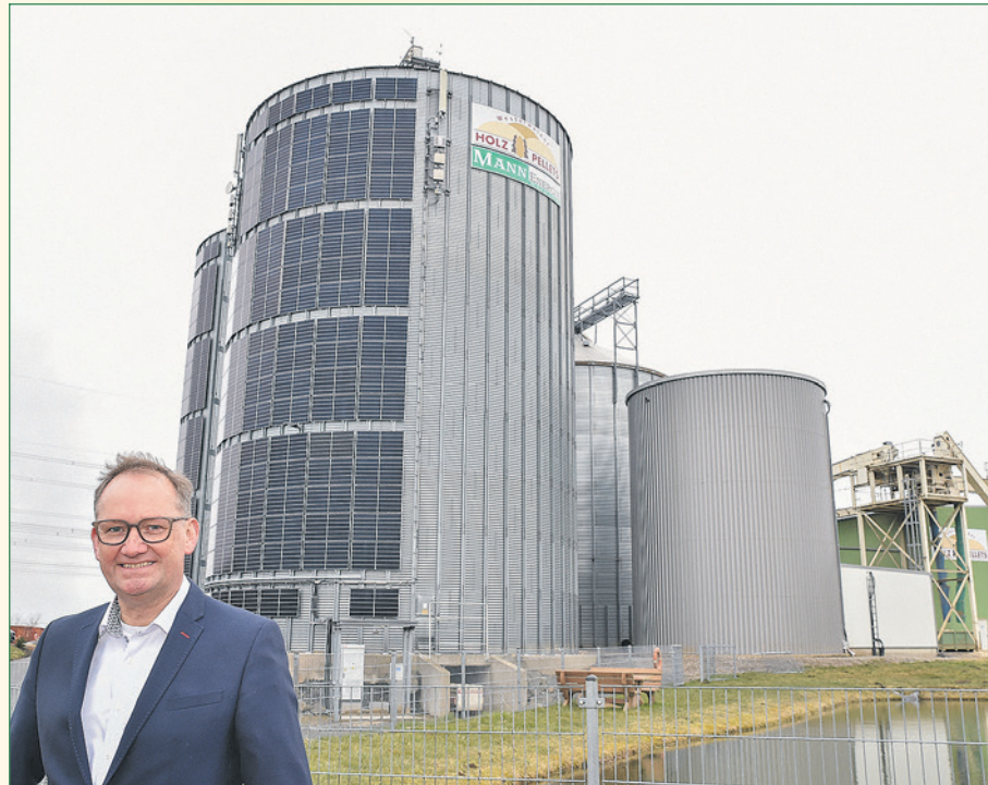
Zuversicht: Markus Mann und sein Team wollen mit Maßnahmen wie den Photovoltaikmodulen auf den Pelletsilos die Versorgung der WWP-Kunden sichern.
