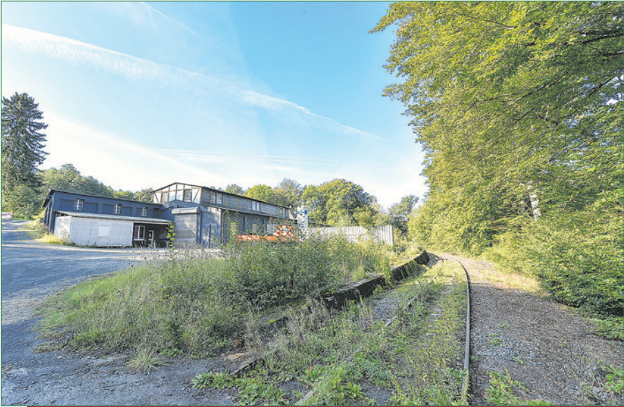
Umschlag: Am Bahnhof Bindweide wird künftig rangiert werden, von dort kommen die Waggons hier an der Rosenheimer Lay an. Da soll in einer ersten Phase auf Lkw umgeladen werden. Langfristig sollen die Züge bis nach Langenbach rollen können.
