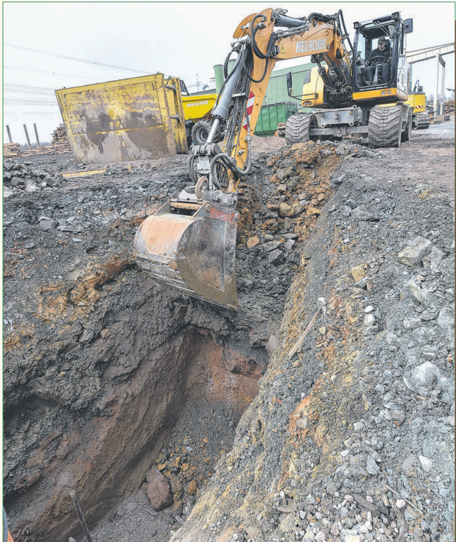
Vorbereitung: Ein Teil der momentanen Arbeit erfolgt schon im Vorgriff auf weitere Zukunftsvorhaben wie die Schnellladestation für E-Lkw.
