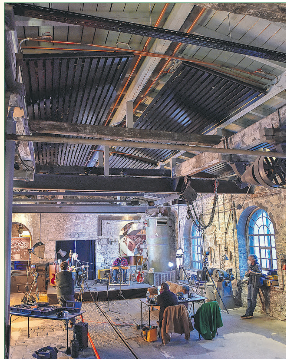
Decke: Über den Musikern sorgen schwarze Heizsegel für ein angenehmes Raumklima.
