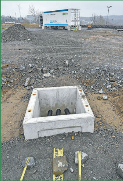
Anschluss: Durch Kabelzieh-schächte werden die Verdrahtungen zwischen Windrädern, Schaltanlagen und dem Speicher gezogen.
