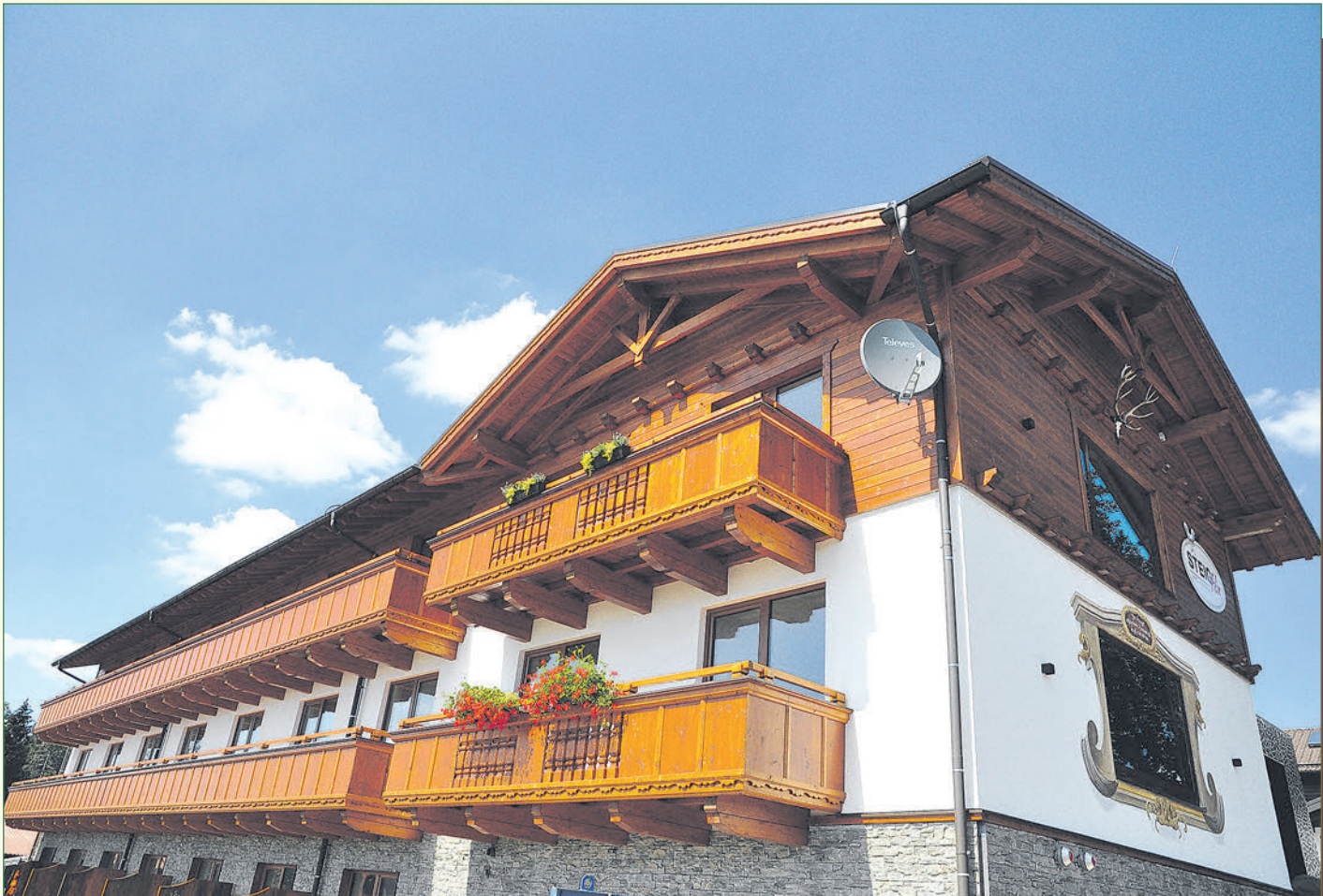
Charakter: Das neue Hotel ist modern-alpin gehalten. Zudem wird es mit „grünem“ „MANN Naturstrom“ betrieben, auf dem Dach gibt es eine Photovoltaikanlage.
