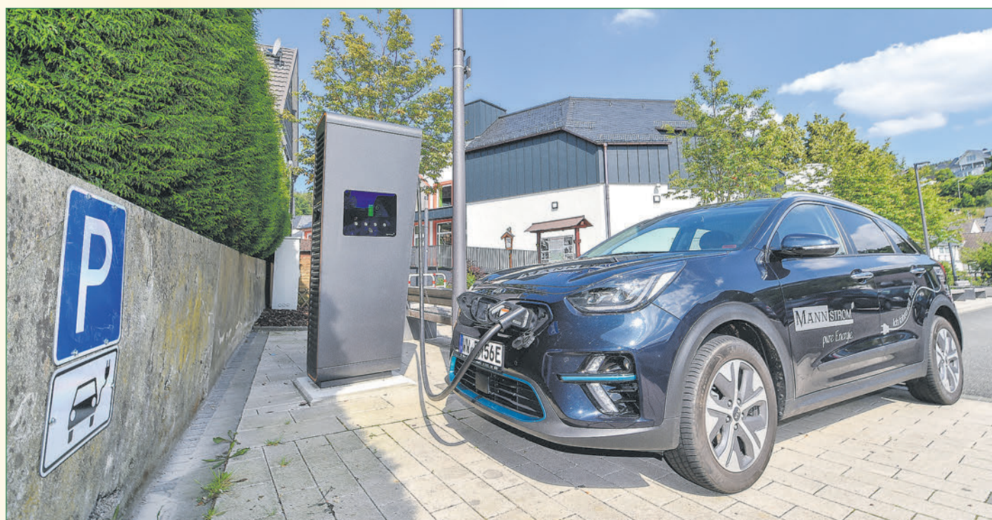
Investition: Mit dem von MANN Naturenergie betriebenen Schnelllader „Juice Ultra“ kann man in Daaden sein Elektroauto mit bis zu 75 Kilowatt laden. Fotos: Schmalenbach
