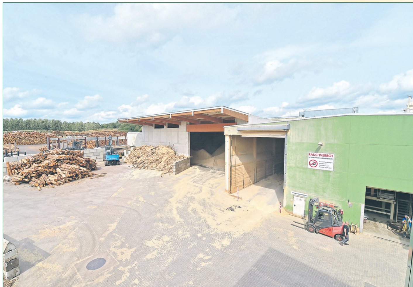
Produktion: Die beim Sägen der Baumstämme anfallenden Späne werden in der grauen Halle trocken bevorratet und in der grünen Halle zu Pellets gepresst. Fotos: Schmalenbach
