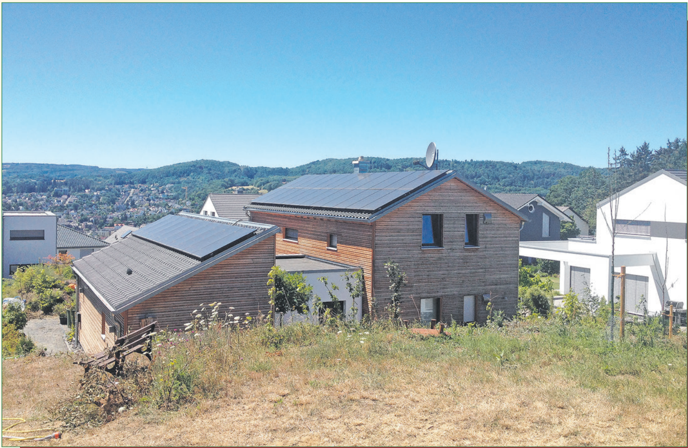
Unterschied: Optisch fällt das Haus im Neubaugebiet im Osten Herborns auf. „Klar, man hätte auch sagen können: Weniger da oben – mehr zum Zeigen an der Fassade oder im Vorgarten“, schmunzelt Matthias Weil und deutet auf die kostspielige Photovoltaikanlage.
