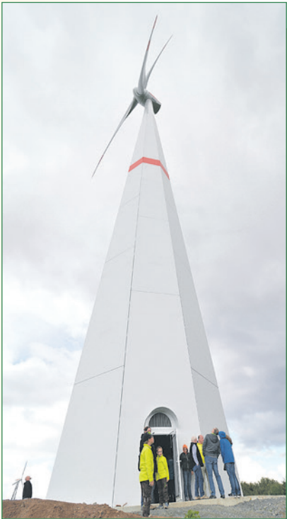
Besuch Das neue Windrad der „WÄLLER ENERGIE eG“ interessiert eine große Zahl der Gäste.
