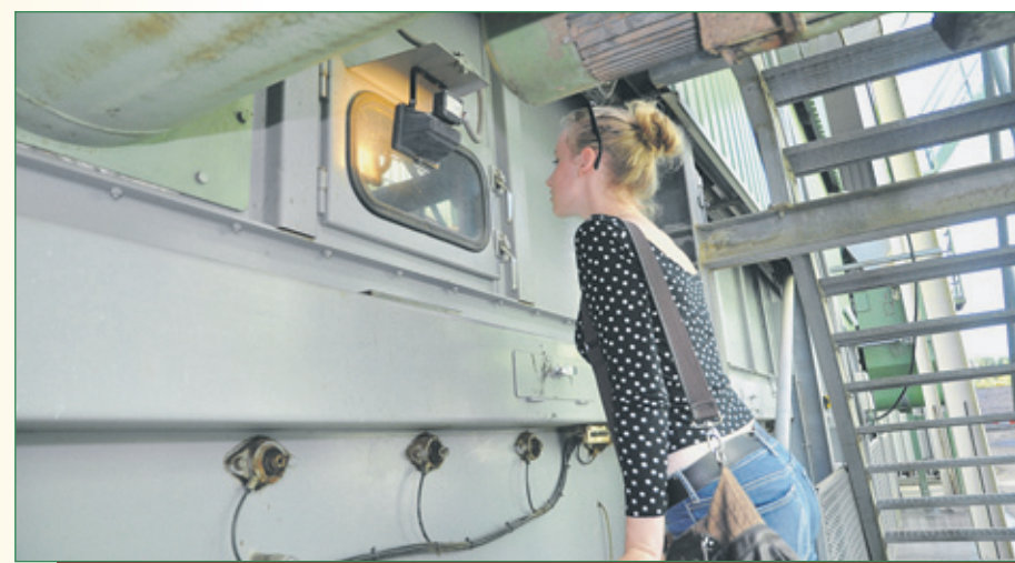
Schauglas: Die Arbeitsweise des Bandrockners interessiert alle in der Gruppe.
