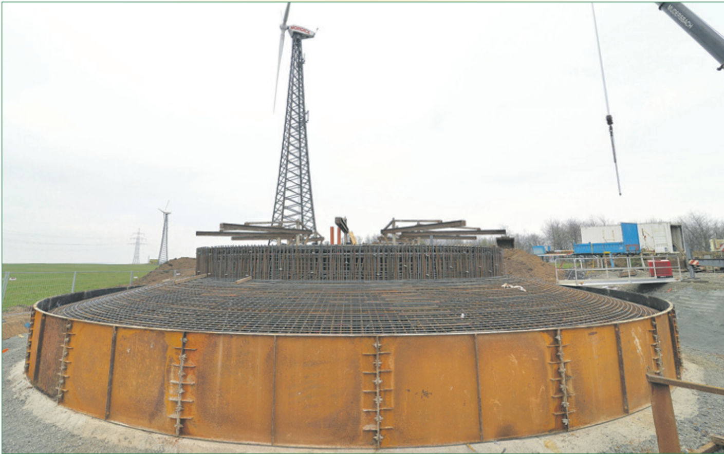
Fundament: Eine Menge Metall für die Armierung haben die Bauarbeiter kreisrund in die Verschalung für den Betonsockel eingebracht. Darauf wird der Turm später zwischen Friedewald und Langenbach solide im Wind stehen.
